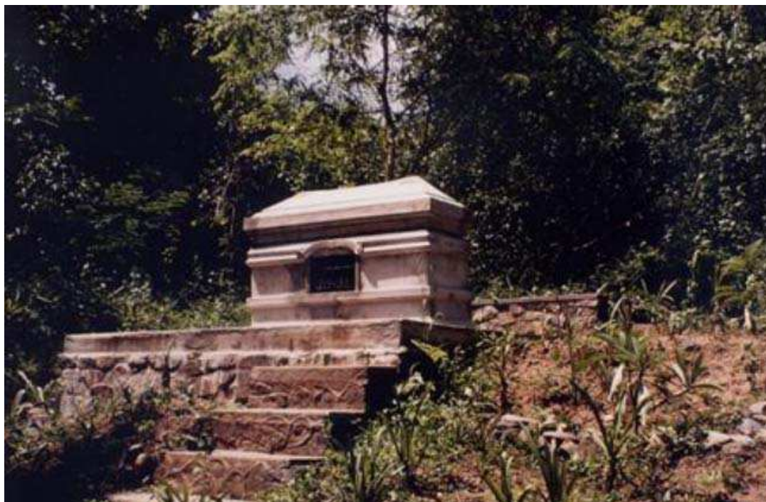
Fig. 2 : Le monument après sa restauration (juillet 1990), photo J. - M. Strobino
